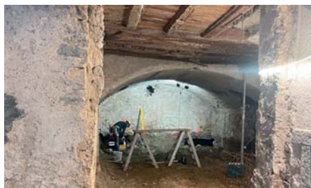
Renforcement des fondations.
