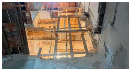
Planchers en reconstruction.
